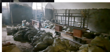
Ремонт, 2021 г. (фото Т.Н. Белкиной)
