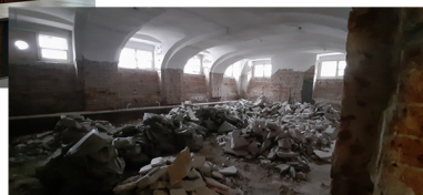
Ремонт, 2021 г. (фото Т.Н. Белкиной)
